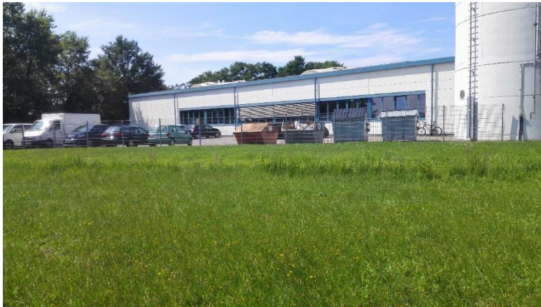
Abbildung 5. Graben (2) im Süd-Osten. 25.07.2016.
