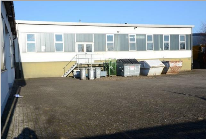
Abb. 4: Teilversiegelte Fläche nordöstlich der Bleichstraße
