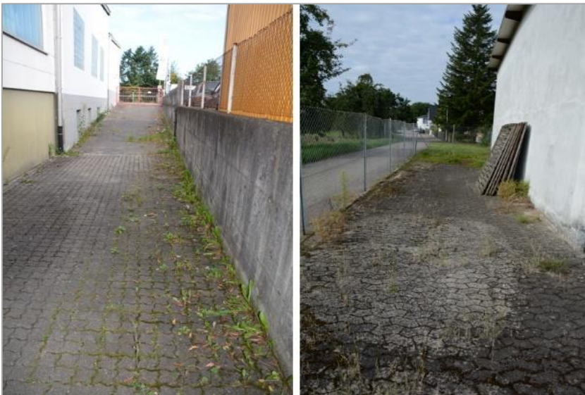
Abb. 6: Teilversiegelte Fläche an der östlichen (Bild links) und an der südlichen Grundstücksgrenze (Bild rechts)
