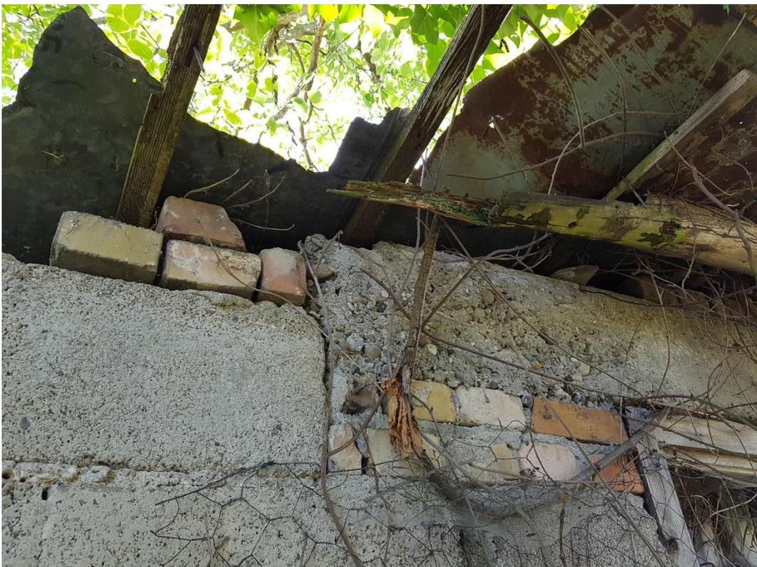
**Abbildung 4.1-3.** Detailaufnahme der Dachkonstruktion auf der Südwestseite des Schuppens.
